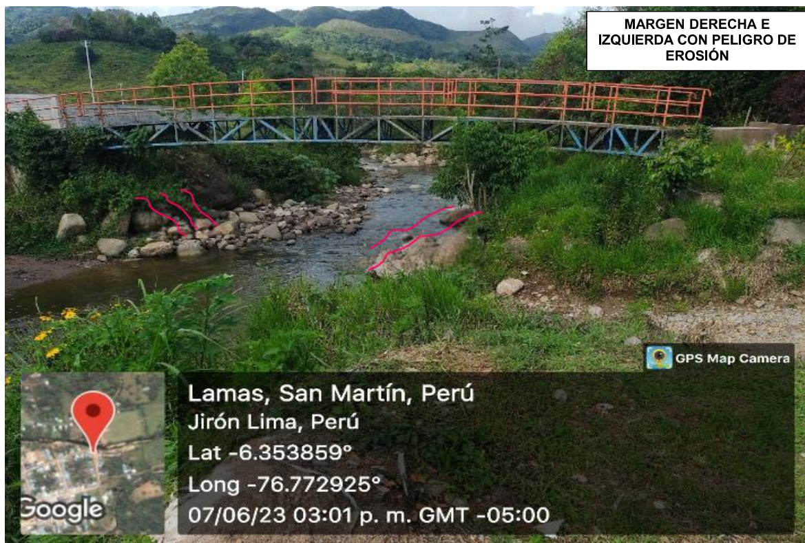
FIGURA N°03: EN LA TEMPORADA DE MAXIMAS AVENIDAS, LA QUEBRADA ASANZA EROSIONA EN AMBAS MARGENES DEL PUENTE TIPO PEATONAL.
